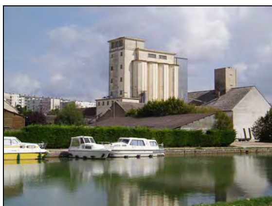
Vue sur la tour CCT depuis les berges du canal
